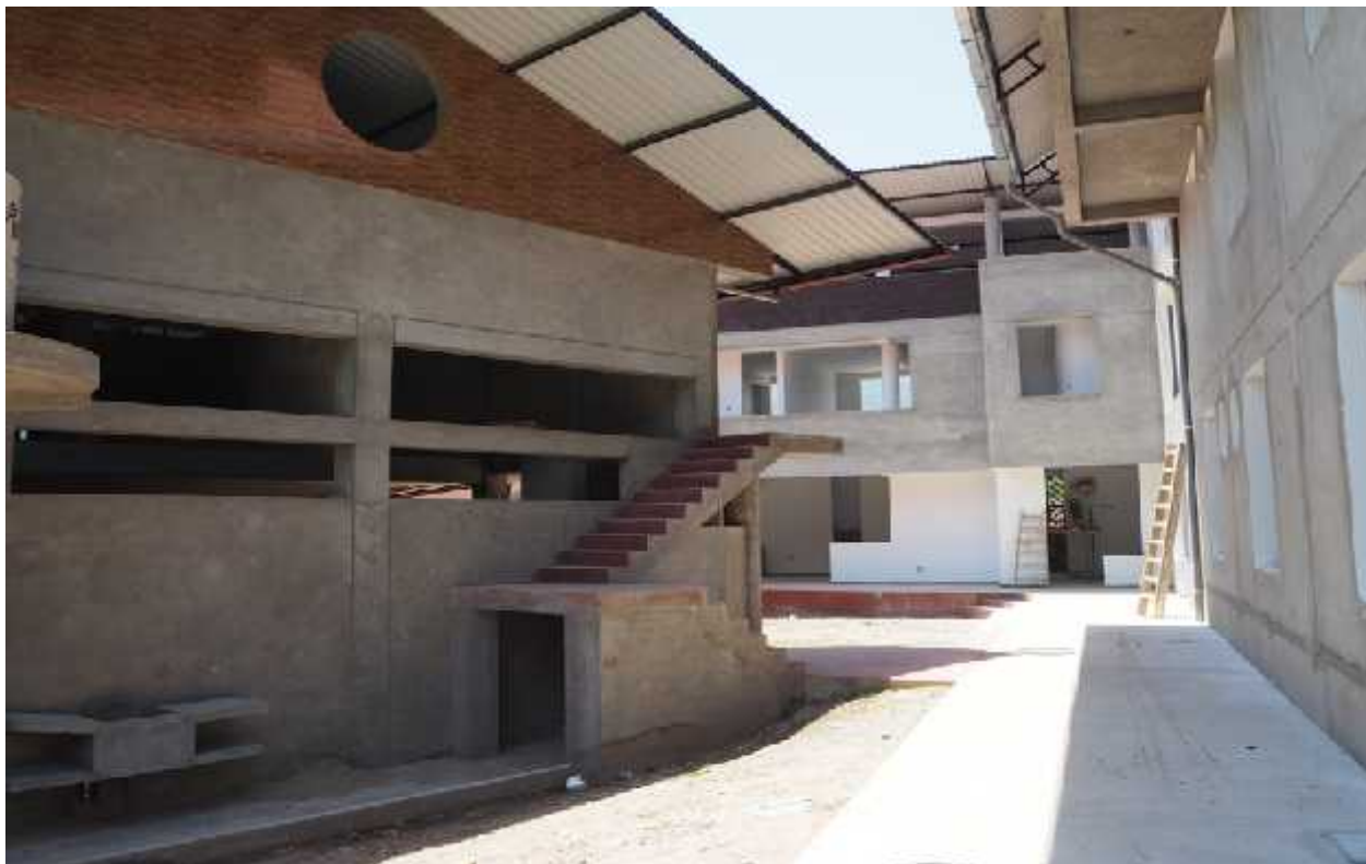
Bakeriet til venstre, og trappen til andre etasje
